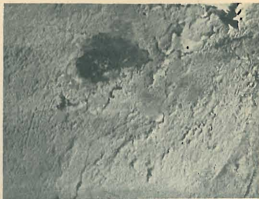
● Lo strato di colore sul muro a fresco, per effetto di essiccamento, si solleva in squame e lamelle.
