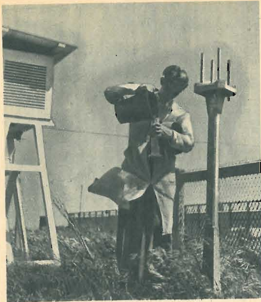
◀ Una stazione meteorologica in aperta campagna: la misura della temperatura (eseguita nella capannina a 2 m al disopra del suolo erboso) e quella della pioggia (raffigurata a lato) danno ogni affidamento; i termometri di queste stazioni indicano infatti aumenti effettivi della temperatura.
